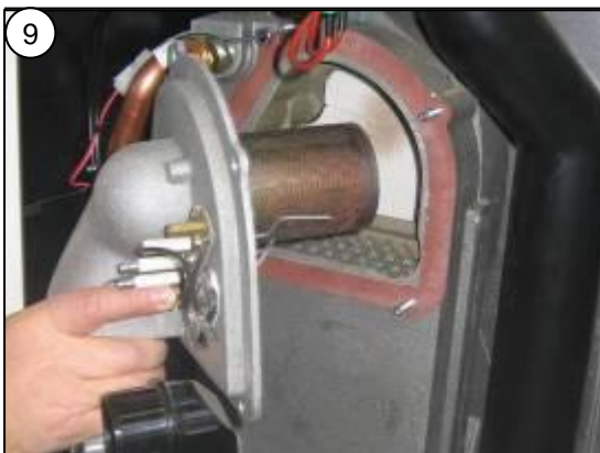
9 Vyjměte z kotle celý hořák s potrubním kanálem a ventilátorem
