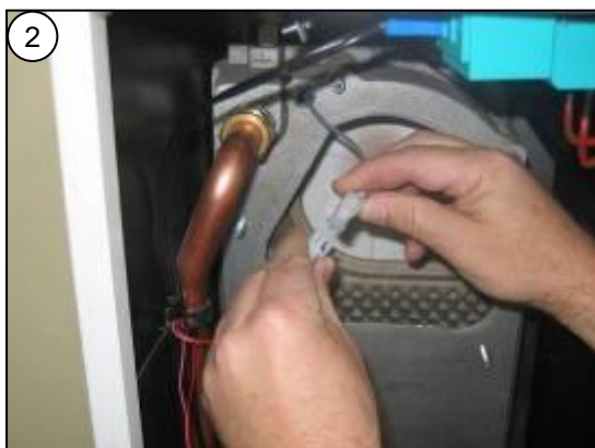
Odpojte konektor čidla rozběhu a zpětného chodu
