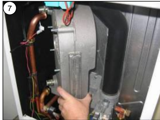
Lehce naklopte tepelný výměník a otočte ve směru hodinových ručiček ca. o 45°, poté vyjměte z krytu
