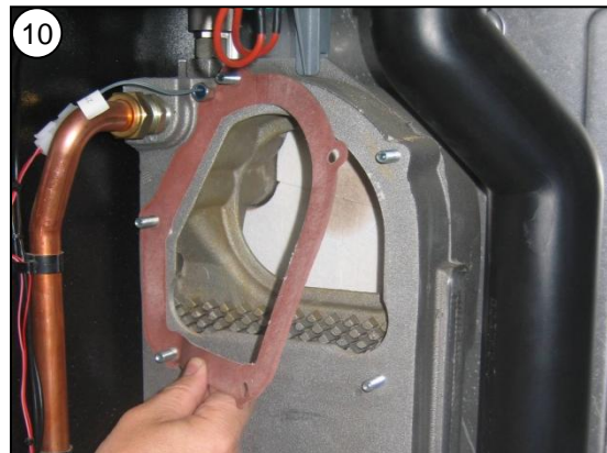
10 Sejměte těsnění krytu hořáku a případně vyčistěte těsnící plochy
