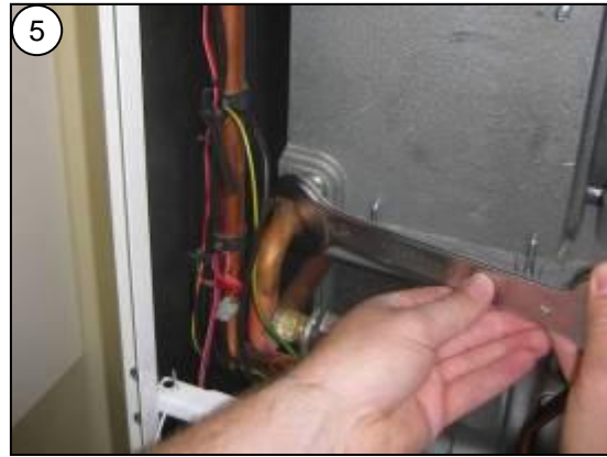
Povolte šroubení rozběhu a zpětného chodu na tepelném výměníku
