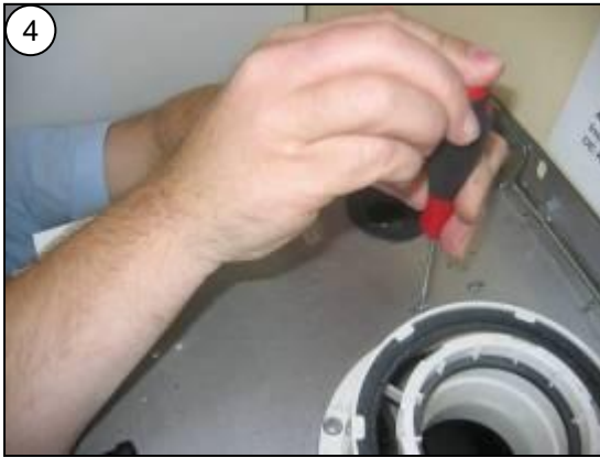
Povolte shora šrouby držáku tepelného výměníku, držák vyjměte čelně
