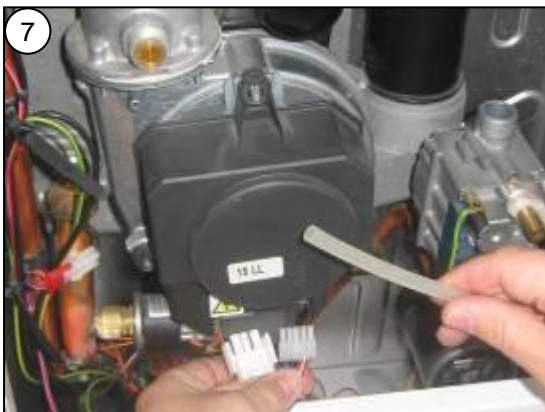
7 Stáhněte plastovou tlakovou hadici a konektor na ventilátoru
