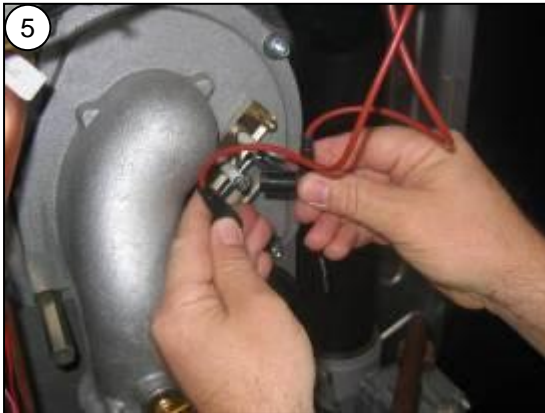
5 Odpojte konektor zapalovací elektrody a konektor uzemnění
