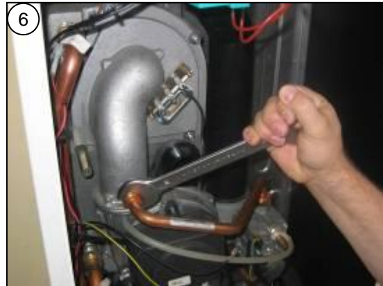
6 Povolte přesuvné matice na plynovém potrubí a vyšroubujte je, vyjměte plynovou trubku a plynovou trysku a těsnění z potrubního kanálu
